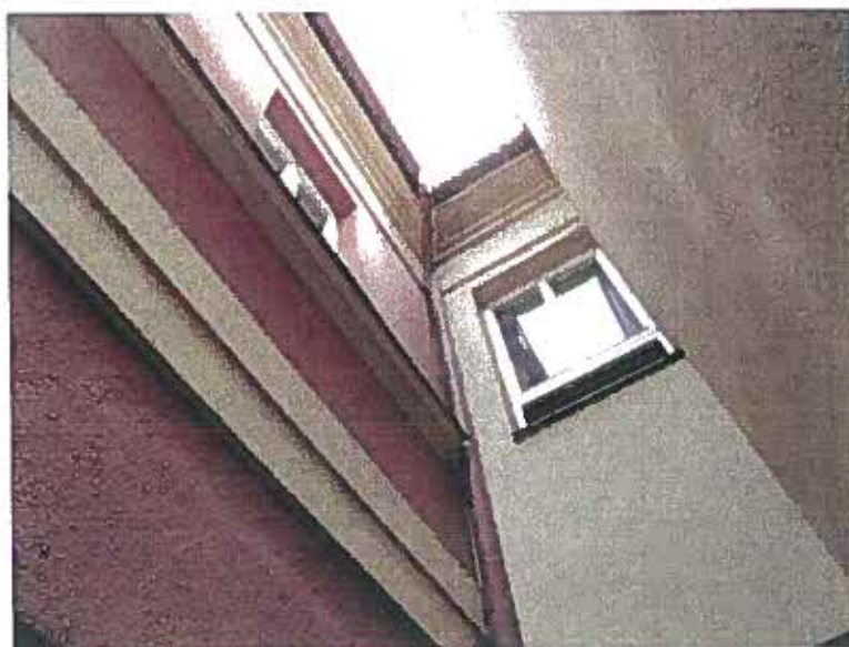
Svod bez většího kotlíku a zářky umístěný mimo úžlabí
