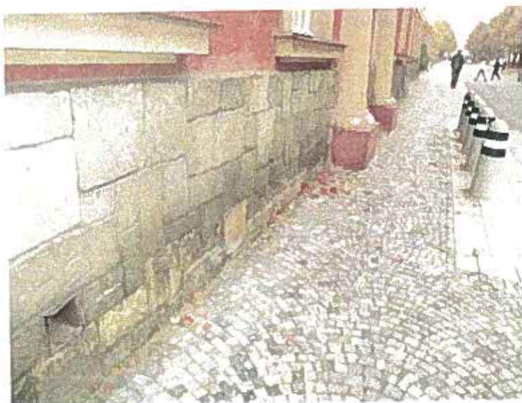
Degradace pískovce v soklu nad chodníkem
