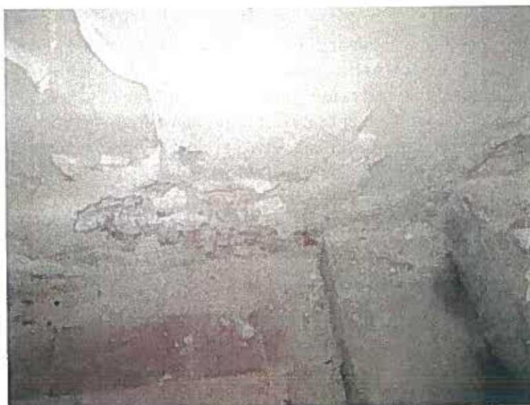
Degradace omítky vlhkostí a krystalizačními tlaky solí (S4)
