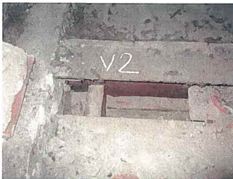
Zhlaví uložená do ocelových nosníků
